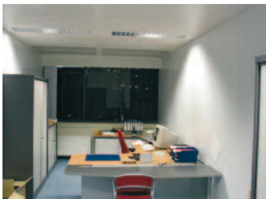
Figuur 33 : Afscherming van de vensteropening d.m.v. afdekzeilen
