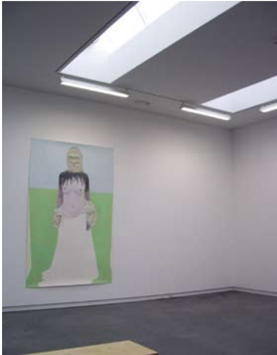
Fig. 8.2 Toepassing van shed- daken met ramen op het noorden. Museum De Pont, Tilburg.
