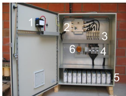
Figuur 7: Condensatorbatterij (bron: Wikipedia) met '5' de condensatoren
