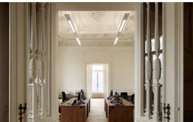
figuur 25 : secretariaat op gelijkvloerse verdieping, voorzien van T5-pendels
